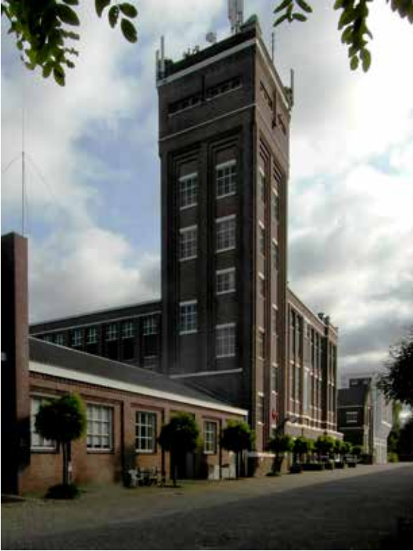
Fabrieksstraat met een imposante watertoren.
