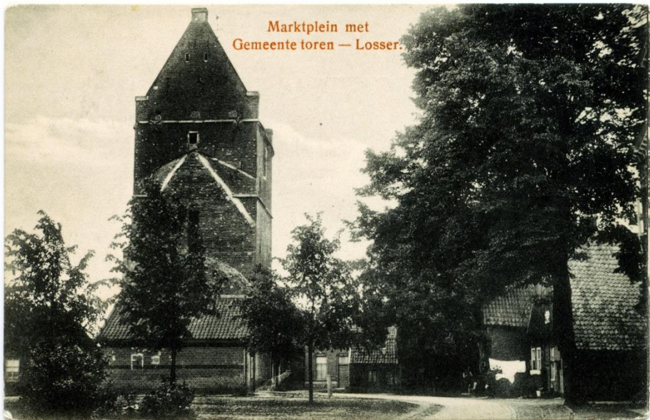
De Martinustoren, vanuit het oosten gezien, na afbraak van de kerk in 1905. Duidelijk zijn nog de sporen van het originele dak en de latere mansardekap te onderscheiden. Aan de voorkant staat het nieuw aangebouwde brandspuithuisje (ca. 1910).
