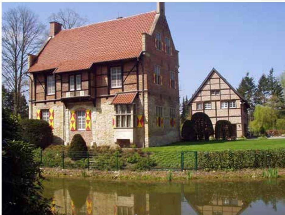
Haus Bisping. De doorgang van het oude poorthuis is nu dicht gemetseld.
