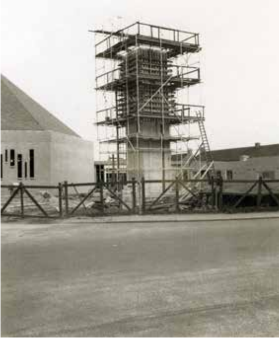
De toren in aanbouw.
