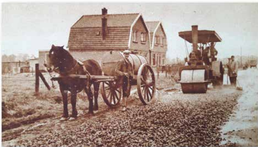
Verharding van de Hoofdstraat in Overdinkel
