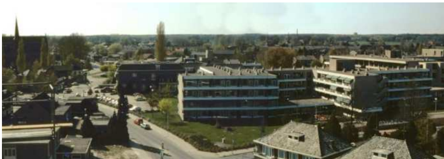
Panorama van het complex, nog met het oude gebouw.
